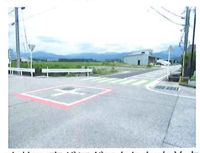
本格工事がほどこされた交差点
